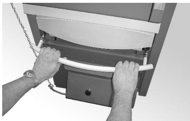
Fot. 8 Regulacja powietrza wtórnego
