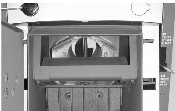
Fot. 7 Otwarta kłapa rozpalania, kłapa czyszczenia odsunięta
