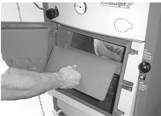
Fot. 12 Wyciągnięcie pokrywy do czyszczenia
