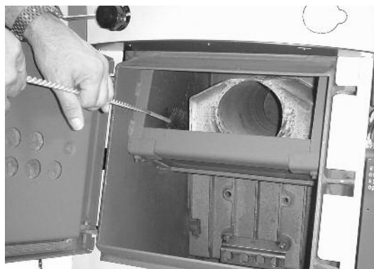
Fot. 13 Czyszczenie wymiennika ciepła
