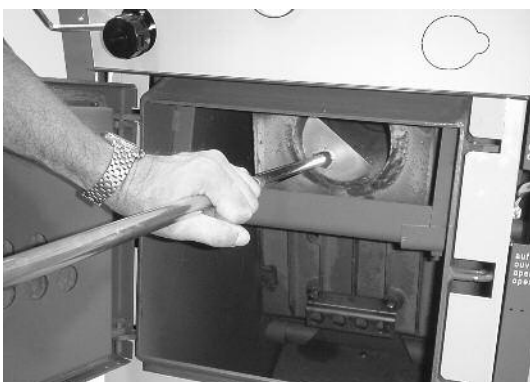
Fot. 14 Czyszczenie czopucha
