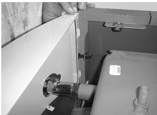
Rys. 22 Zaczepy obudowy przedniej umieścić w odpowiednie otworach
