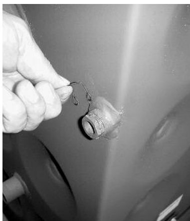
Rys. 5 Usunąć zabezpieczenie czujnika
