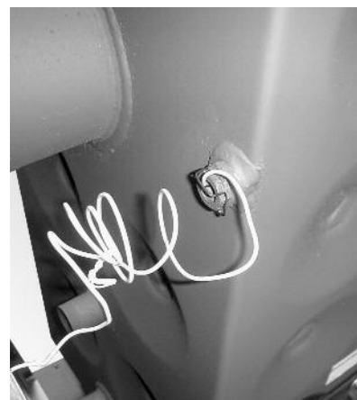
Rys. 7 Zabezpieczyć czujnik
