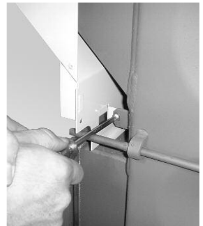
Rys. 13 Przykręcić ścianę przednią 2x na dole
